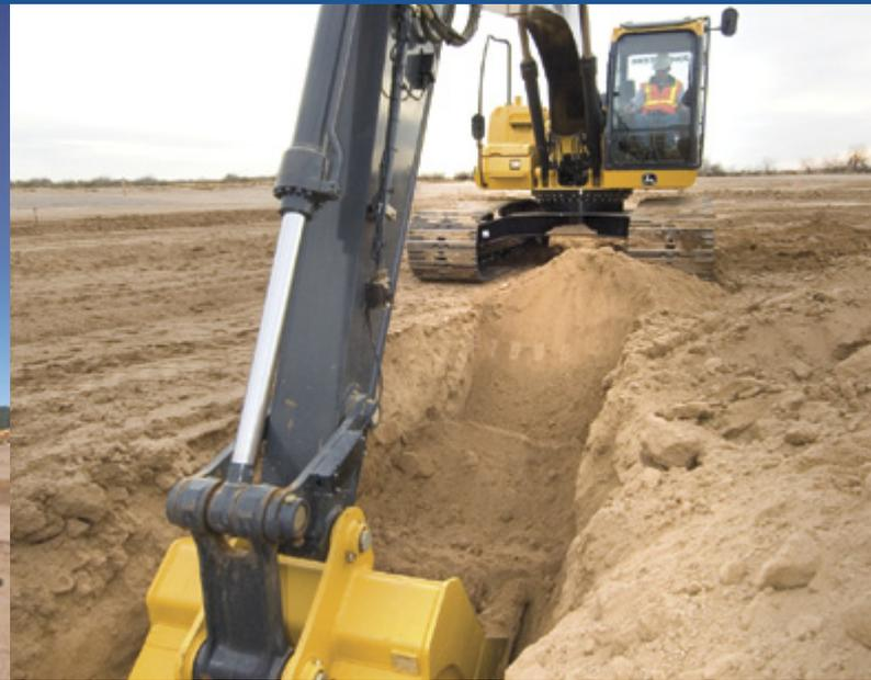
El sistema Trimble 2D para excavadoras es un sistema de control de profundidad y de pendiente para trabajos de excavación, zanjas, nivelación y de perfilado. El sistema utiliza un sensor angular AS300, un sensor de doble eje AS310 y un detector láser LC300 para medir la relación entre la superestructura, la pluma, el balancín y la cuchara a fin de determinar dónde está y dónde debería estar el filo, dirigiendo al operador a la profundidad. Ha sido diseñado para excavadoras
