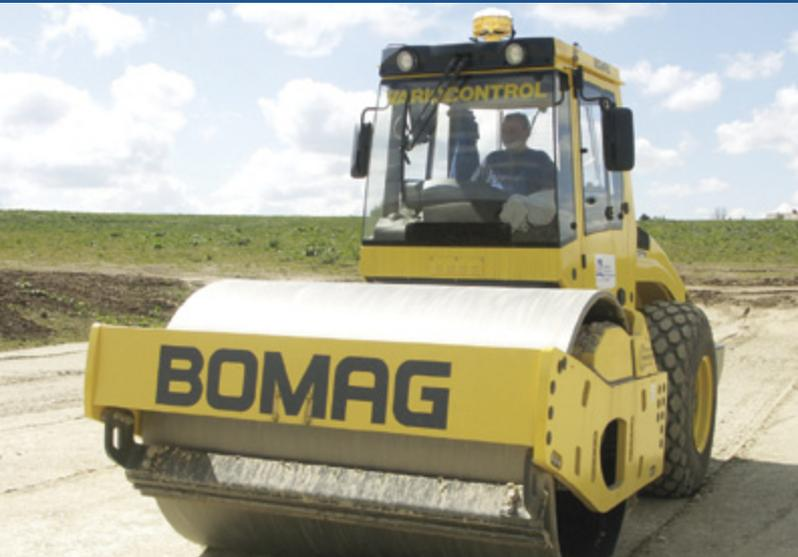
Una vez que se logra nivelar, la mayoría de los proyectos de movimientos de tierra requieren que el material subrasante se compacte de acuerdo con la densidad deseada para un incremento de la duración, estabilidad y capacidad de soporte de carga.
