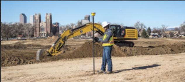
El sistema de posicionamiento Siteworks de Trimble para topógrafos de obra está formado por la Smart Antenna GNSS SPS986 de Trimble, el controlador TSC7 y el software de campo Siteworks. Gracias a él, los topógrafos pueden trabajar con complejos modelos en 3D, recopilar más rápidamente grandes conjuntos de datos, visualizar más fácilmente complejos modelos en 3D y trabajar con eficacia de día o de noche.
